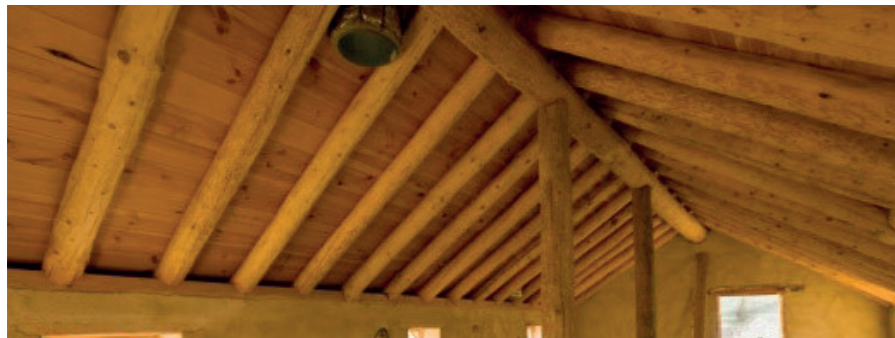
Vigas en rollizo
