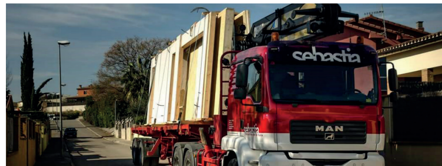
Muros autoportantes de entramado ligero
