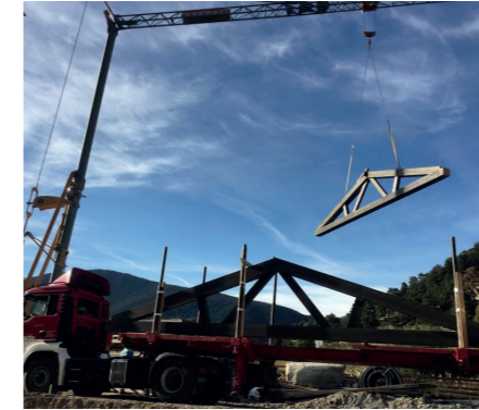
Montaje en obra
