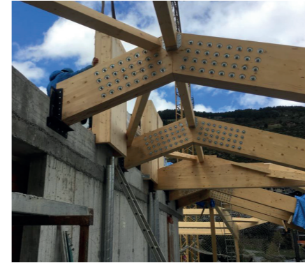
Casa en construcción
